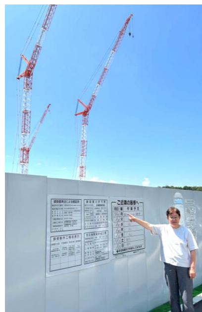
現地調査の山中たい子県議予定候補(AI データセンター建設地・7/25)
