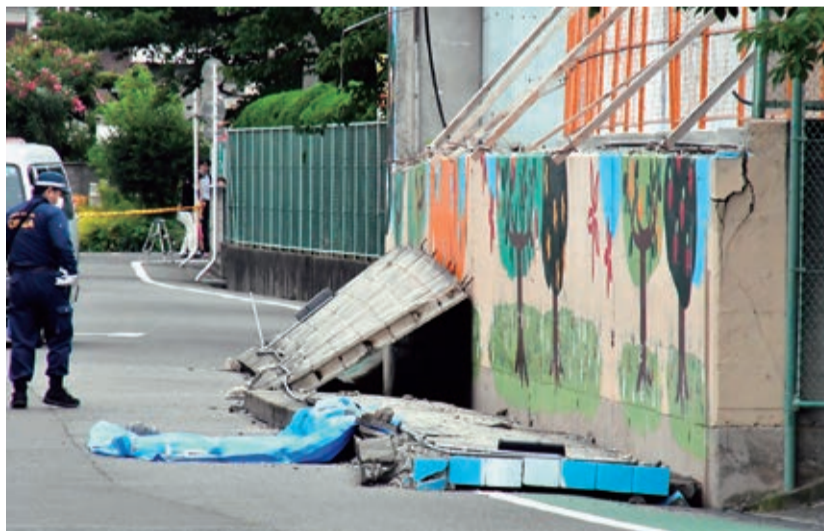
女兒が亡くなったブロック塀倒壊の事故現場=6月19日、大阪府高槻市
