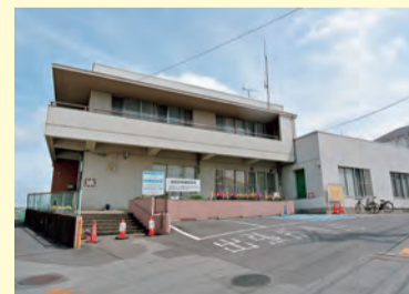
改修が始まる増尾近隣センター
