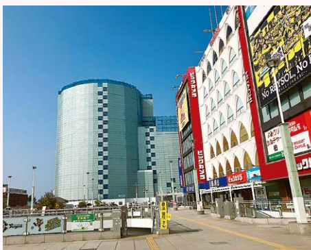
解体工事が進む旧そごう柏店本店
