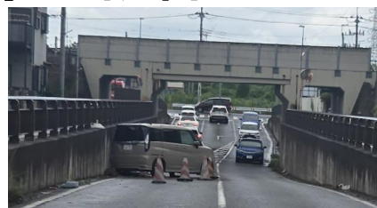
旭町消防署近くのアンダーパス
