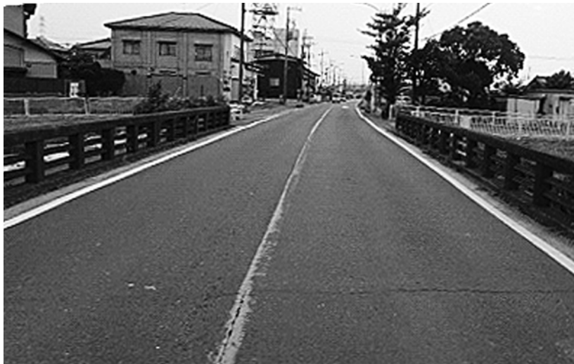
小谷堀橋の写真
