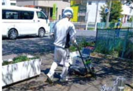
ハンディ型の地中レーダーによる調査
